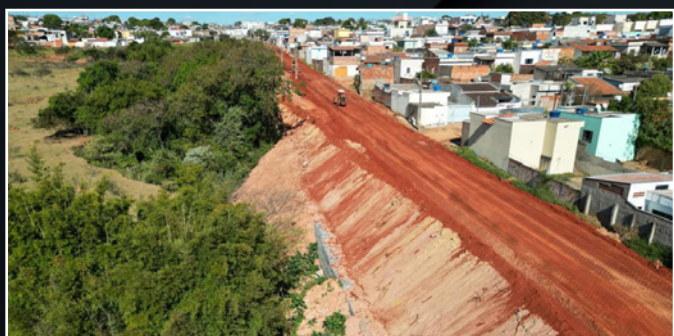
Terraplenagem da Rua Niterói, no município de Passos - MG.
