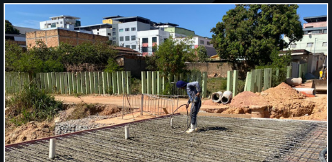
Concretagem de tabuleiro de ponte em estrutura mista, localizada no município de Nova Serrana, MG.
