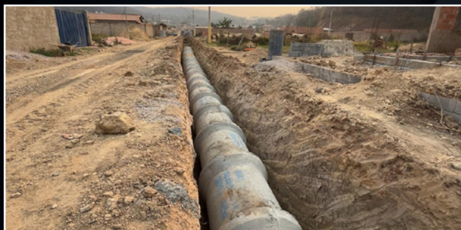
Implantação de rede de drenagem com tubo de concreto, no município de Cachoeira da Prata, MG.
