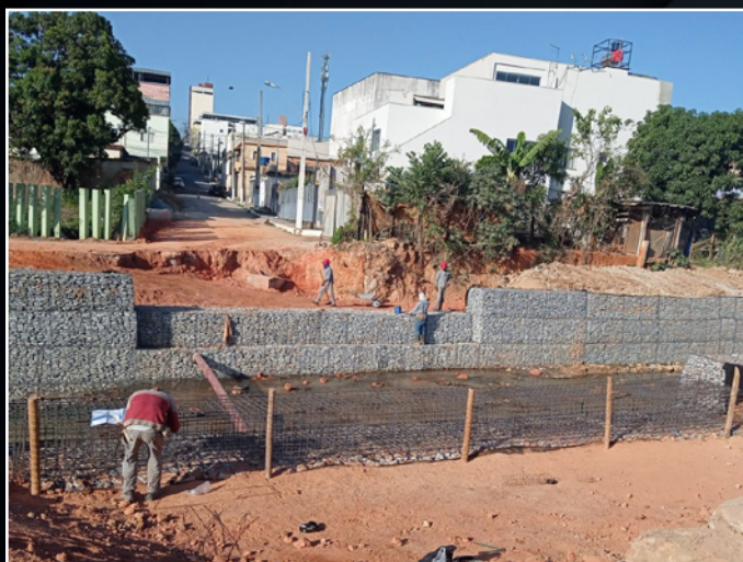
Estabilização de talude em gabião para execução de ponte no município de Nova Serrana, MG.
