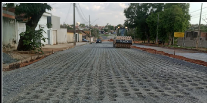
Execução de base em BGS da Avenida Dalton, no município de Sete Lagoas, MG.
