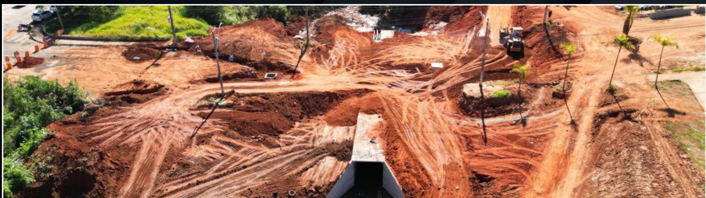
Terraplenagem para implantação de travessia na Av. das Nações.
