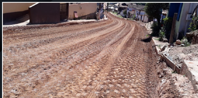
Regularização do subleito no distrito de Córregos, em Conceição do Mato Dentro, MG.
