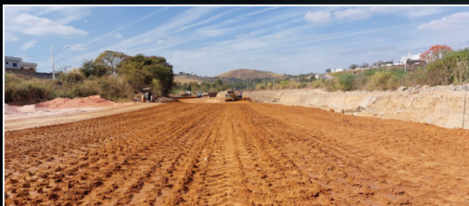
Terraplenagem para implantação de canal aberto.
