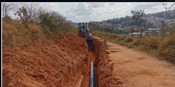
Execução de adutora no município de Barbacena, MG.
