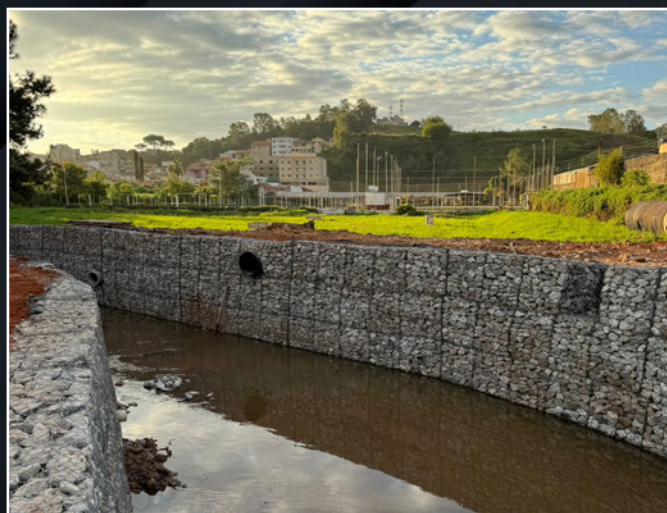
Execução de contenção das margens do Ribeirão das Mortes, localizado no município de Pouso Alegre, MG.
