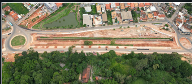
Terraplenagem para implantação de canal aberto.
