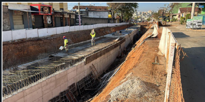
Macrodrenagem da Av. Pio XII, em galerias moldadas in loco, no município de Contagem, MG.
