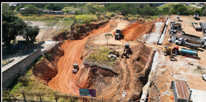
Terraplenagem de empreendimento localizado no município de Contagem, MG.
