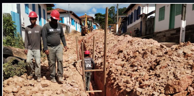
Implantação do sistema de esgoto no distrito de Córregos, em Conceição do Mato Dentro, MG.
