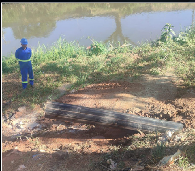
Execução de rede de esgoto utilizando MND (Método Não Destrutivo).
