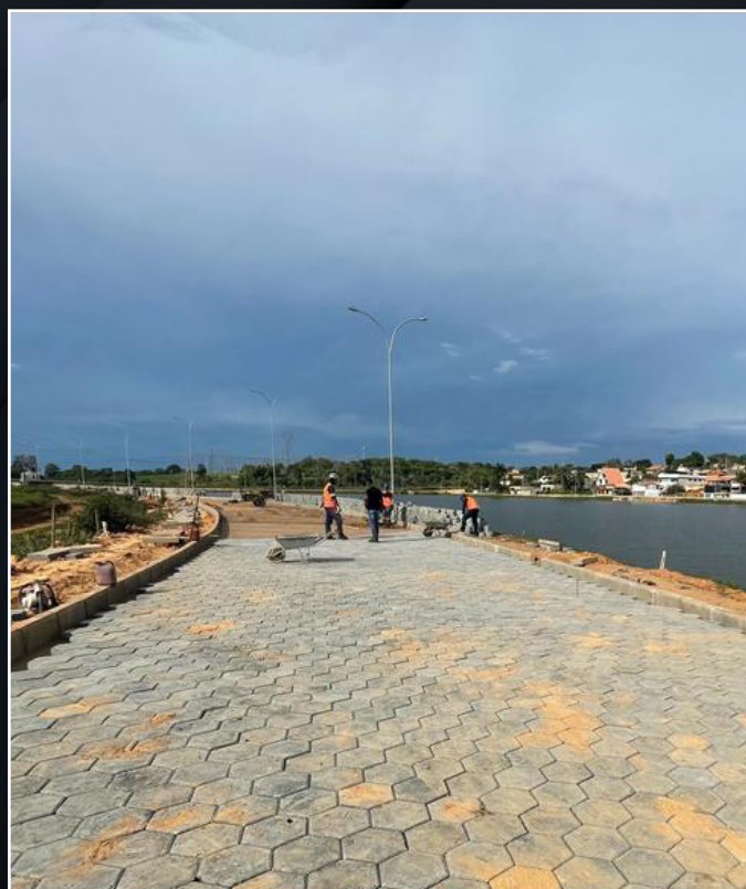
Pavimentação da Av. Copacabana com blocos sextavados, no município de Pimenta, MG.
