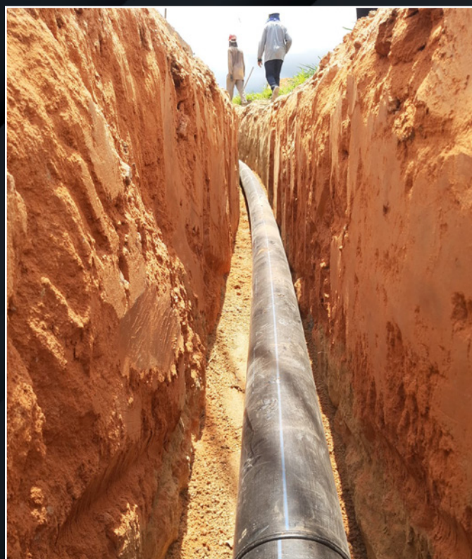
Execução de rede adutora em tubo PEAD, no empreendimento Parque Cerrado, Santa Luzia, MG.
