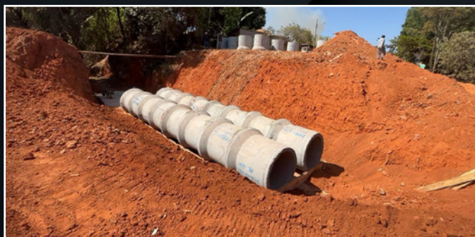
Drenagem com tubo de concreto armado, no município Sete Lagoas, MG.
