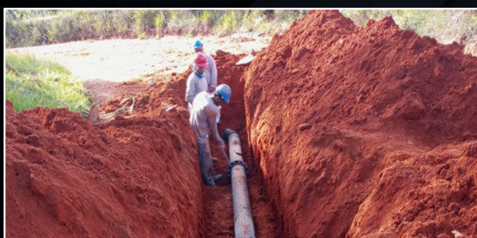
Execução de rede de água em ferro fundido, no distrito de Amarantina, Ouro Preto, MG.
