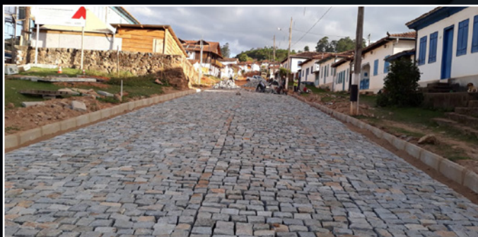
Pavimento paralelepípedo do distrito de Córregos, em Conceição do Mato Dentro, MG.
