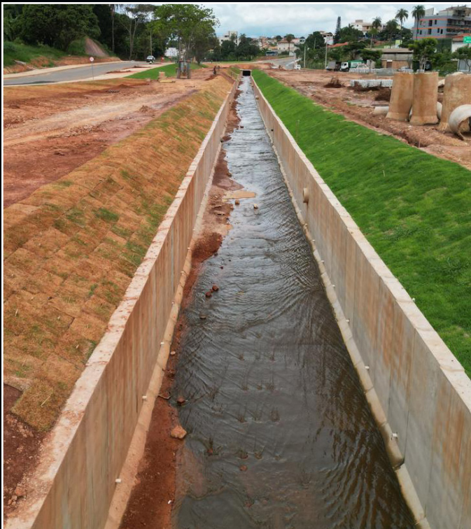
Execução de canal aberto da bacia do Córrego Fundo, localizado no município de Igarapé, MG.
