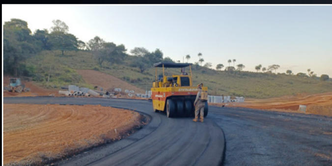
Pavimentação em CBUQ da Av. Duque de Caxias, localizada no município de Igarapé, MG.
