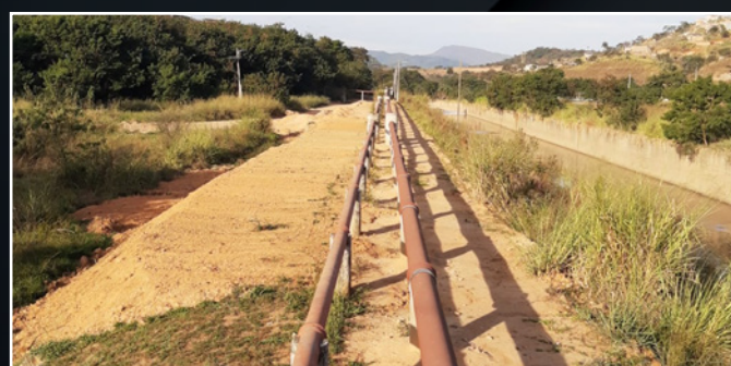
Execução de interceptor aéreo em ferro fundido, no empreendimento Parque Cerrado, Santa Luzia, MG.
