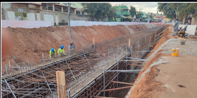
Galerias moldadas in loco para melhorias do sistema de drenagem da Avenida Pio XII, localizada em Contagem, MG.
