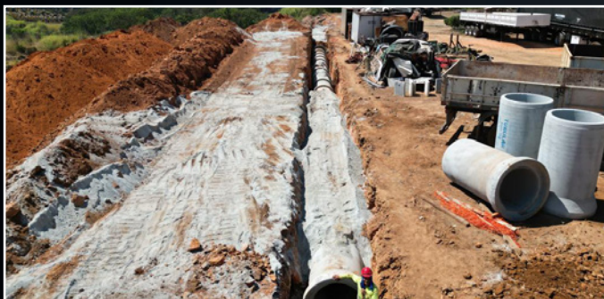
Implantação de rede de drenagem com tubo de concreto armado, em empreendimento localizado no município de Contagem, MG.
